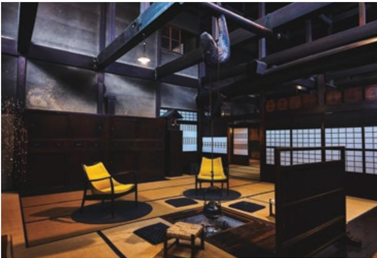
1879（明治12）年、高山の大工・川尻治助が江戸時代の建築様式を忠実に再現して建てた日下部邸。豪快に組み上げられた梁と広々とした土間から、匠が思う存分腕を振るったことがわかる。構造部分は釘を使わず、すべて木組みだけで造られている。上がり框（かまち）には、地元の作家・川上博一さんの椅子。隣接の離れを改修した1日1組限定のヴィラ「谷屋」に宿泊すれば閉館後にプライベートラウンジとして利用できる
