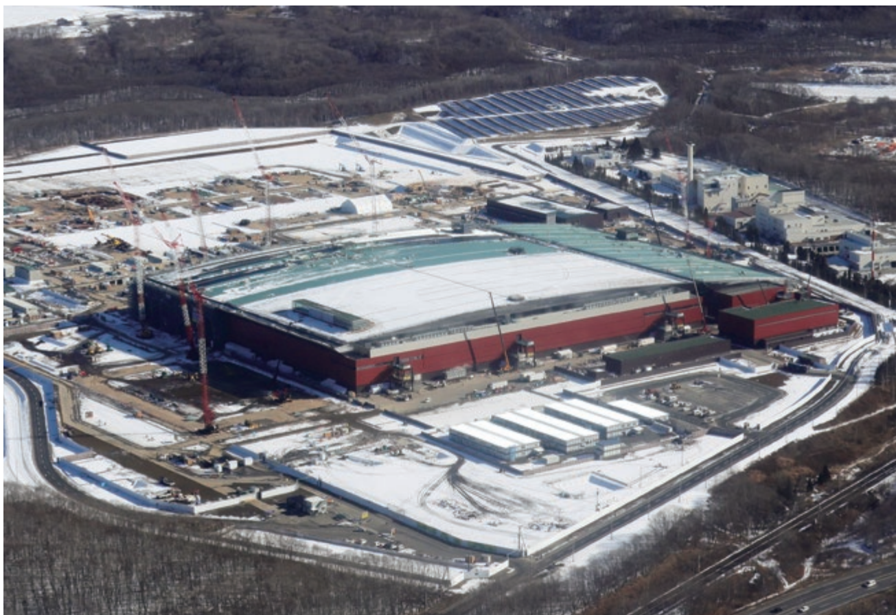
北海道千歳市で建設中のラピダスの工場（2025年1月28日撮影）
