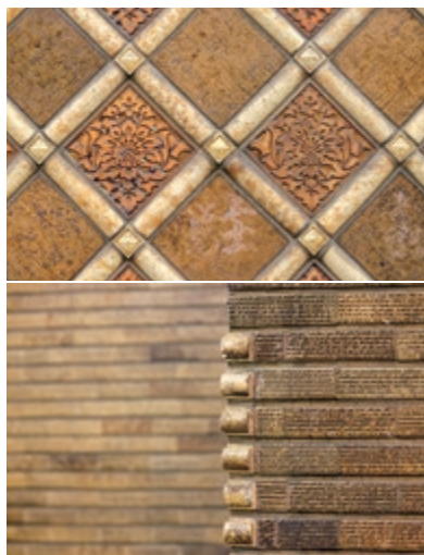
〔右〕「鴨川をどり」の看板が目を引く先斗町歌舞練場の正面玄関 〔左上〕なまこ壁を思わせる腰壁部分には、赤茶色の花文レリーフと布目のタイルが交互に貼られている 〔左下〕建物全体を覆うのは横長のスクラッチタイル
