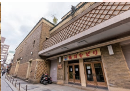
〔右〕「鴨川をどり」の看板が目を引く先斗町歌舞練場の正面玄関 〔左上〕なまこ壁を思わせる腰壁部分には、赤茶色の花文レリーフと布目のタイルが交互に貼られている 〔左下〕建物全体を覆うのは横長のスクラッチタイル
