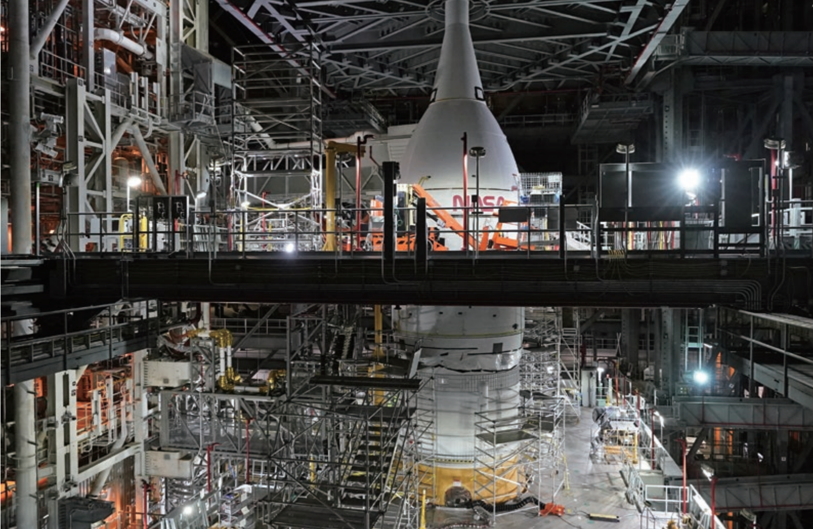
建設中のSLS。高さは322フィート（約98メートル）あり、米ニューヨークの「自由の女神」（93メートル）より高い AP/AFL0
