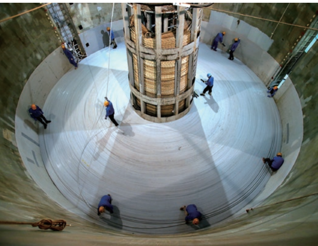
敷設船内のタンクに巻かれて積み込まれる海底ケーブル
